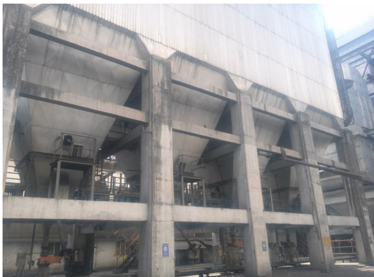
ESP at TTP 15 MW
