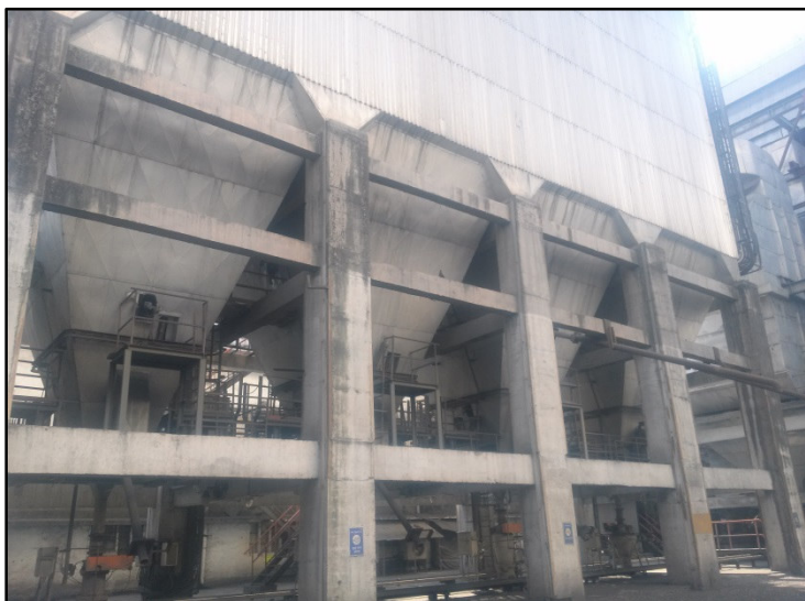
ESP at TTP 15 MW
